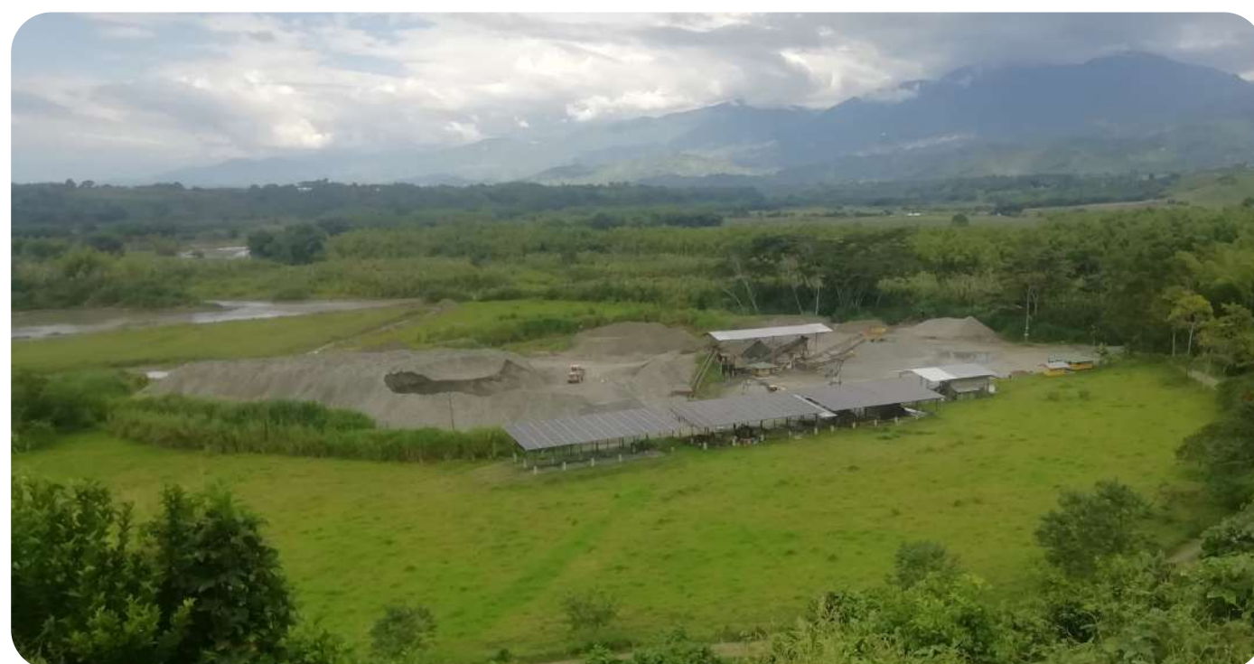
..... Sistema solar ARISOL 2021
